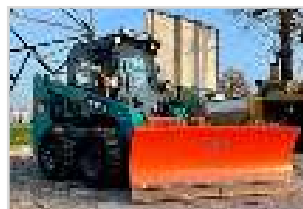
Строительные работы в Италии
